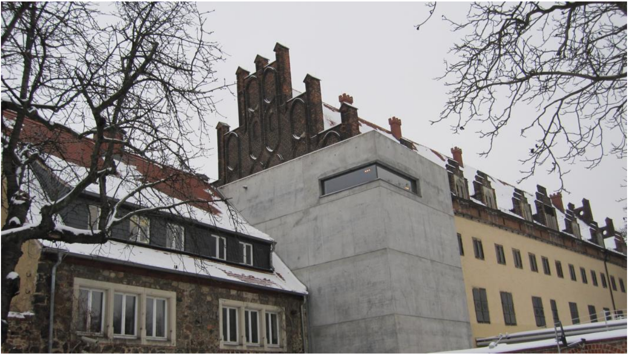
Betonanbau Zwischen Luther- und Direktorenhaus
