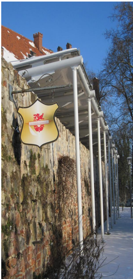
Überdachung des "Katharinengartens"
